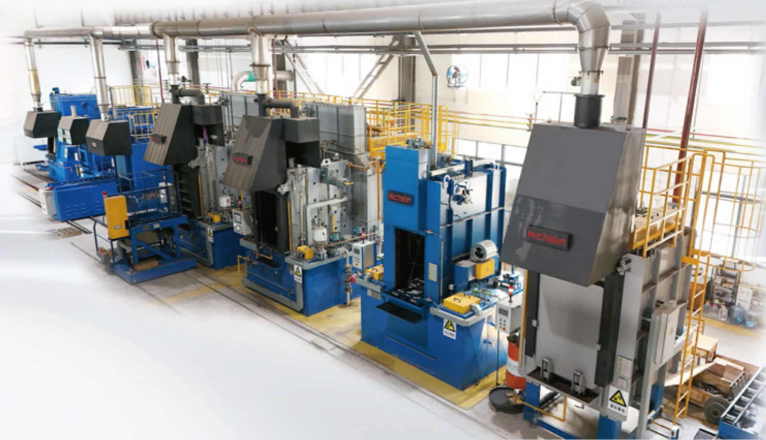
多功能炉生产线
