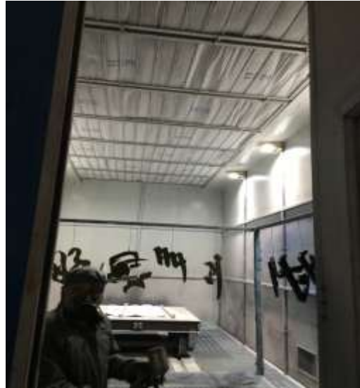
钣金件车间喷涂废气治理设备 (密闭式喷漆烤漆房+顶棉+地棉)
