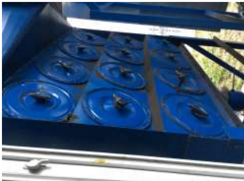
喷砂废气除尘设备 (多级滤芯除尘器)
