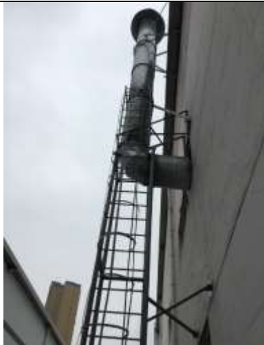
机械三分厂喷涂废气治理措施 (密闭喷漆房+活性炭吸附+光氧催化 +15m 排气筒)
