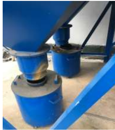
喷砂废气除尘设备 (集尘筒)
