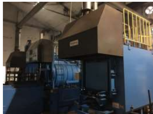
密闭式热处理废气治理措施 (活性炭吸附+15m 排气筒)
