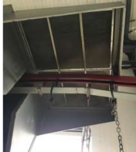
固化烘干废气治理设备 (活性炭吸附设备)
