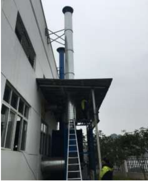
钣金件车间喷涂废气治理措施 (密闭喷漆房+活性炭吸附+光氧催化 +15m 排气筒)
