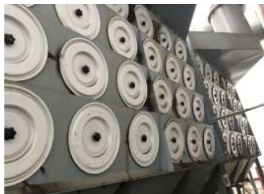
抛丸废气治理设备 (多级滤芯除尘器)
