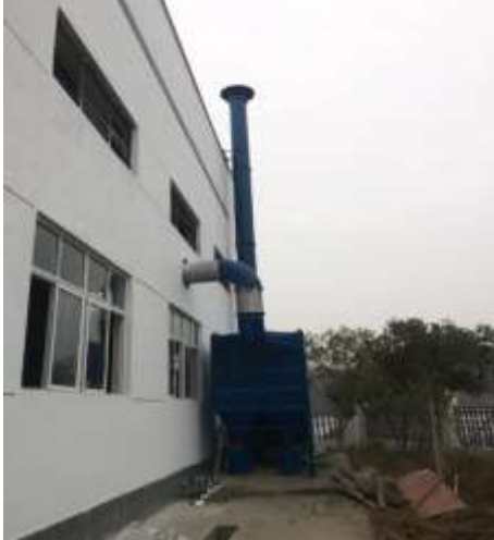
喷砂废气治理措施 (多级滤芯除尘+15m 排气筒)
