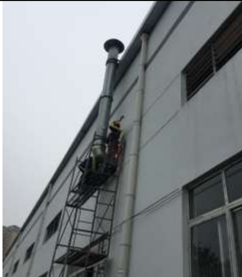
固化烘干废气治理措施 (活性炭吸附+15m 排气筒)
