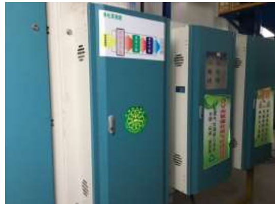
钣金件车间喷涂废气治理设备 (UV 光氧催化净化设备)
