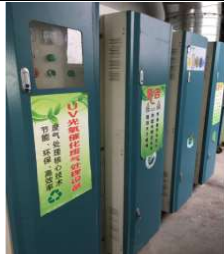
机械三分厂喷涂废气治理设备 (UV 光氧催化净化设备)
