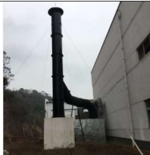
抛丸废气治理措施 (旋风+多级滤芯过滤+15m 排气筒)
