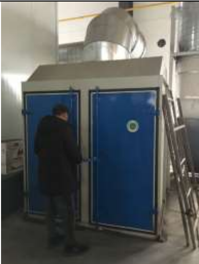
机械三分厂喷涂废气治理设备 (活性炭+过滤棉)
