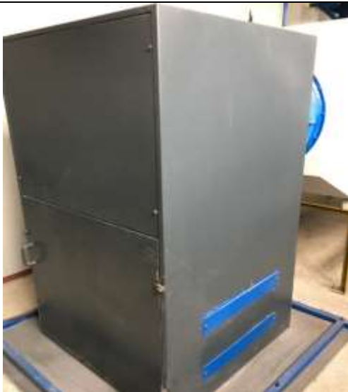
钣金件车间喷涂废气治理设备 (活性炭+过滤棉废净化设备)
