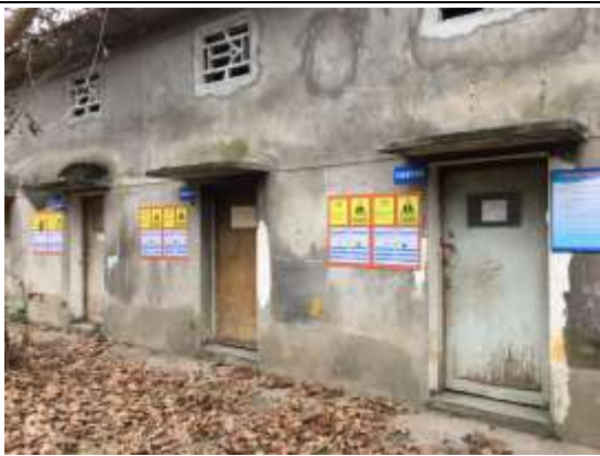
标准化危废贮存间 (具备防渗、防雨、防流失等条件)
